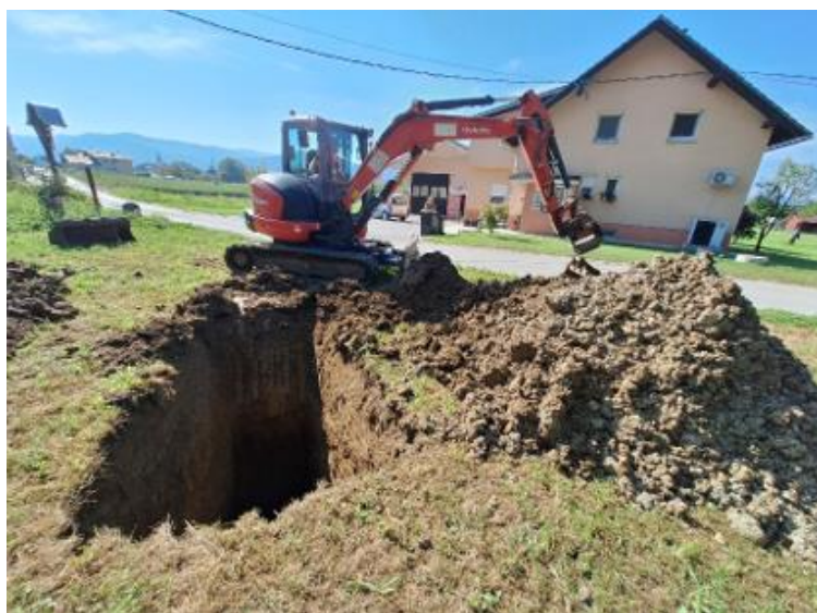
Slika 6: Izkop na lokaciji 1.
