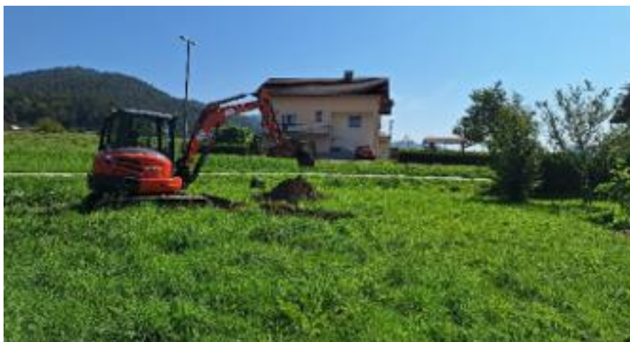
Slika 8: Izkop na lokaciji 4.
