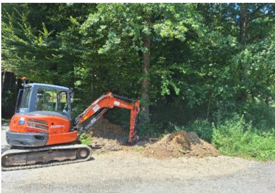
Slika 10: Izkop na lokaciji 3.
