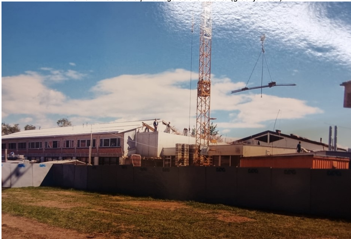
Slika 4: Nadzidava prvotnega dela SV trakta (gradnja 2007)
