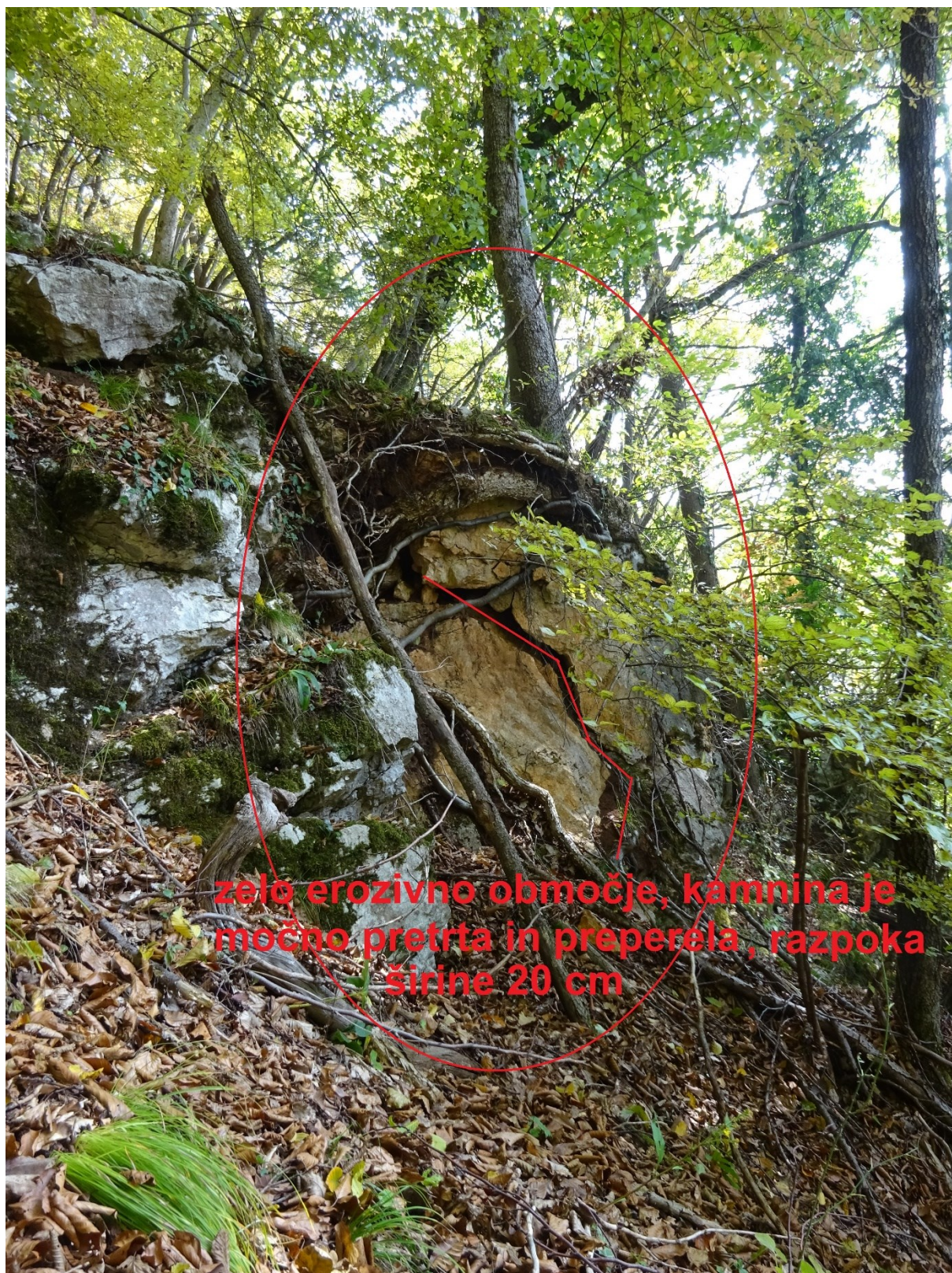
Slika 5: Skrajni zahodni del skalnega čoka 2.
