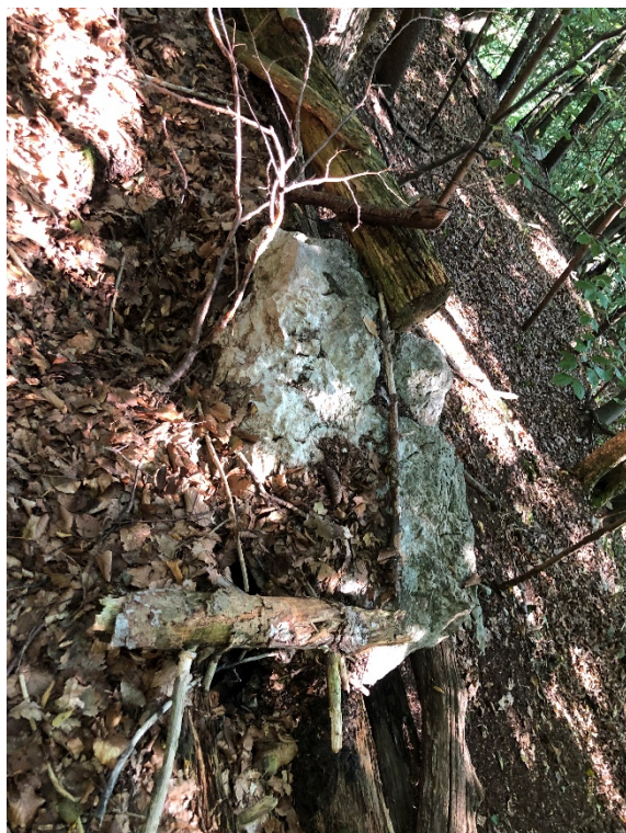
Slika 12. Skalni balvan velikosti okoli 1m 3 ujet v lesene ovire.
