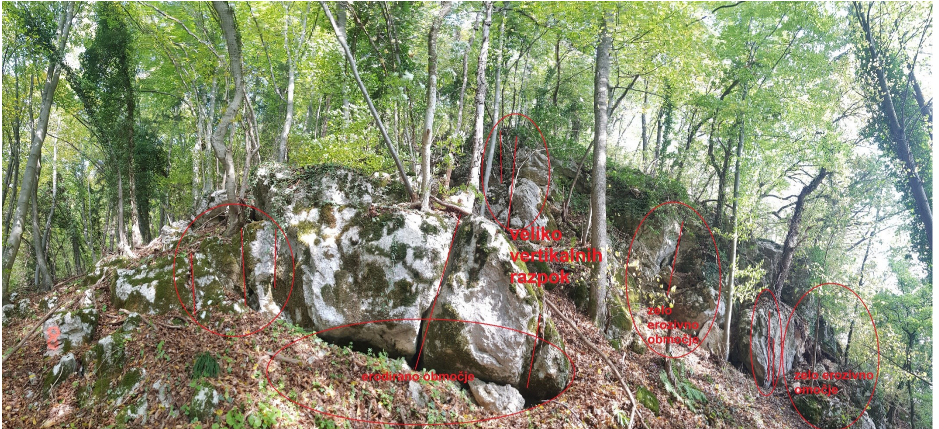
Slika 3: Fotografija zajeta iz zahodnega spodnjega dela skalnega čoka 1, z označenimi potencialno nevarnimi predeli.
