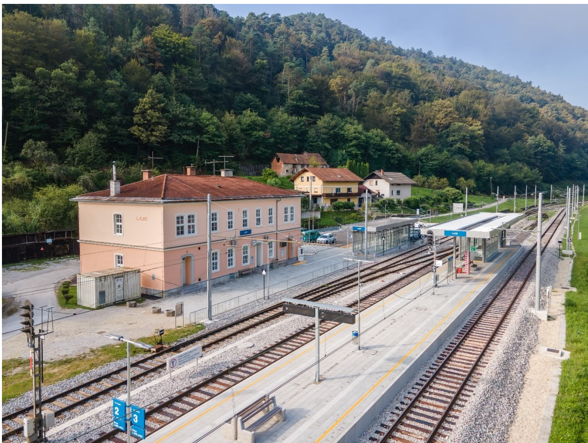
Železniško postajališče Laze ob železniški progi Ljubljana–Zidani Most.. / Avtor: I. Marjanović, 2026
